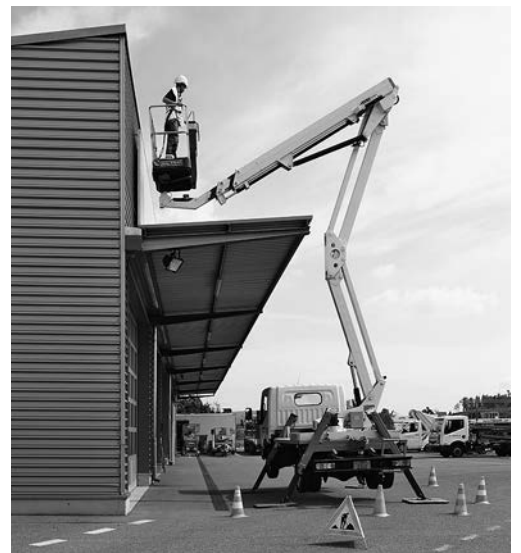
Bild 4: Der Arbeitsplatz ist so abzusichern, dass Passanten nicht in den Gefahrenbereich der Hubarbeitsbühne treten.
